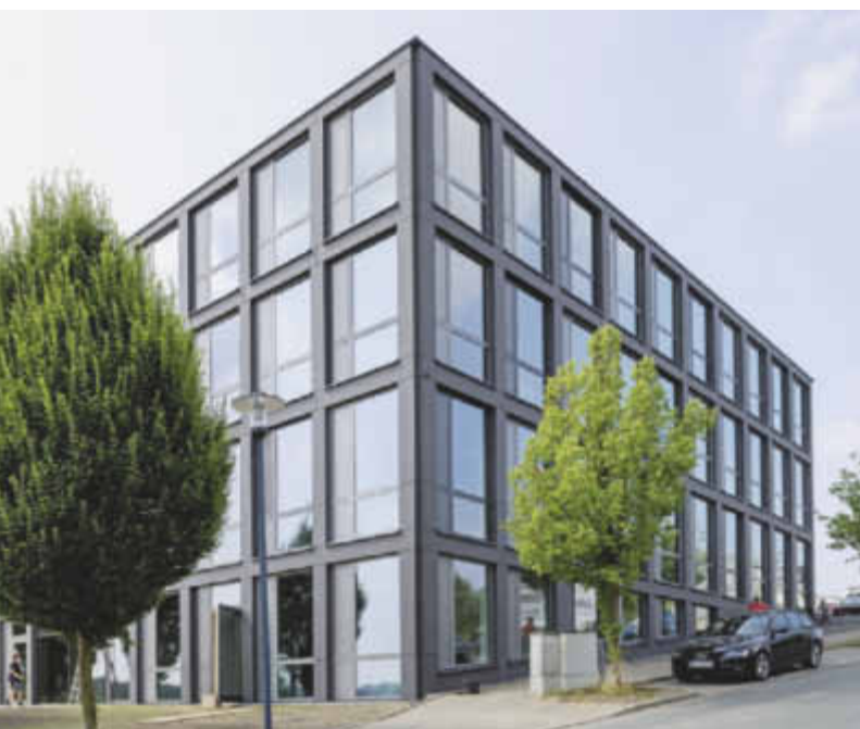
Die verglasten Fassadenflächen sind mit Sonnenschutzglas plus Wärmeschutzglas realisiert, teilweise ergänzt durch innenliegenden Blendschutz.
