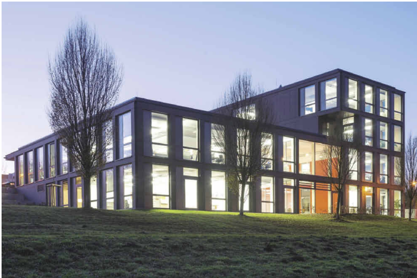
„Blue Office“ ist ein zukunftsweisendes Bürogebäude am östlichen Rand des Technologie-Quartiers in Querenburg.
